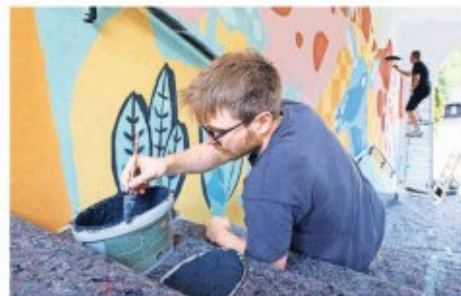
Wegen des Denkmalschutzes und der alten Bausubstanz kamen Graffiti mit Spraydosen nicht in Betracht. Die Jugendlichen malten stattdessen mit Pinsel und Silikatfarbe.
